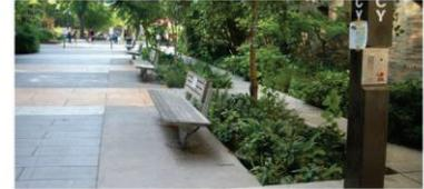
Figura 11. Esempio di strada senza cordoli per il convogliamento delle acque di pioggia nelle aree di infiltrazione. Fonte: Woods Ballard et al. 2015. "The SuDS Manual"
