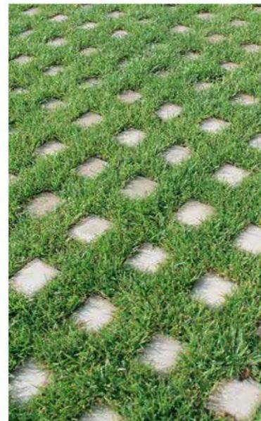
Diverse tipologie di pavimentazioni drenanti che garantiscono un'infiltrazione parziale a confronto: asfalto o calcestruzzo poroso, allettamento masselli con materiale permeabile e ghiaia rinverditata o sterrato.
